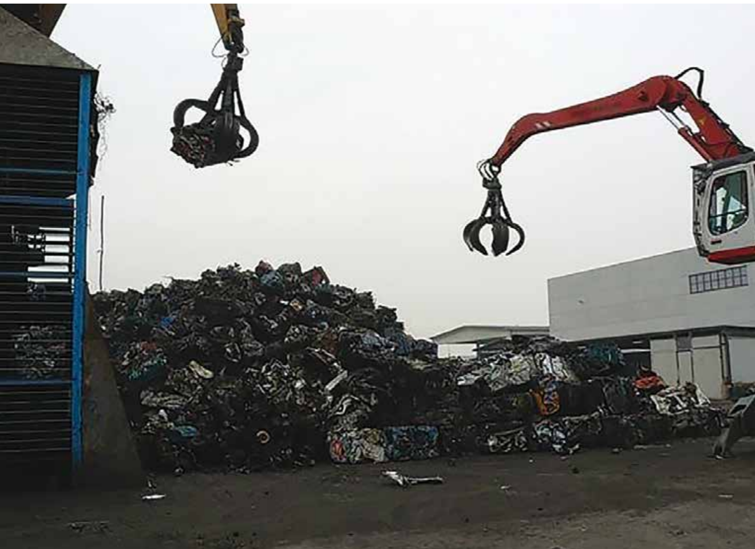
Foto 5.07 Frantumatore rifiuti ferrosi Fonte ISPRA
