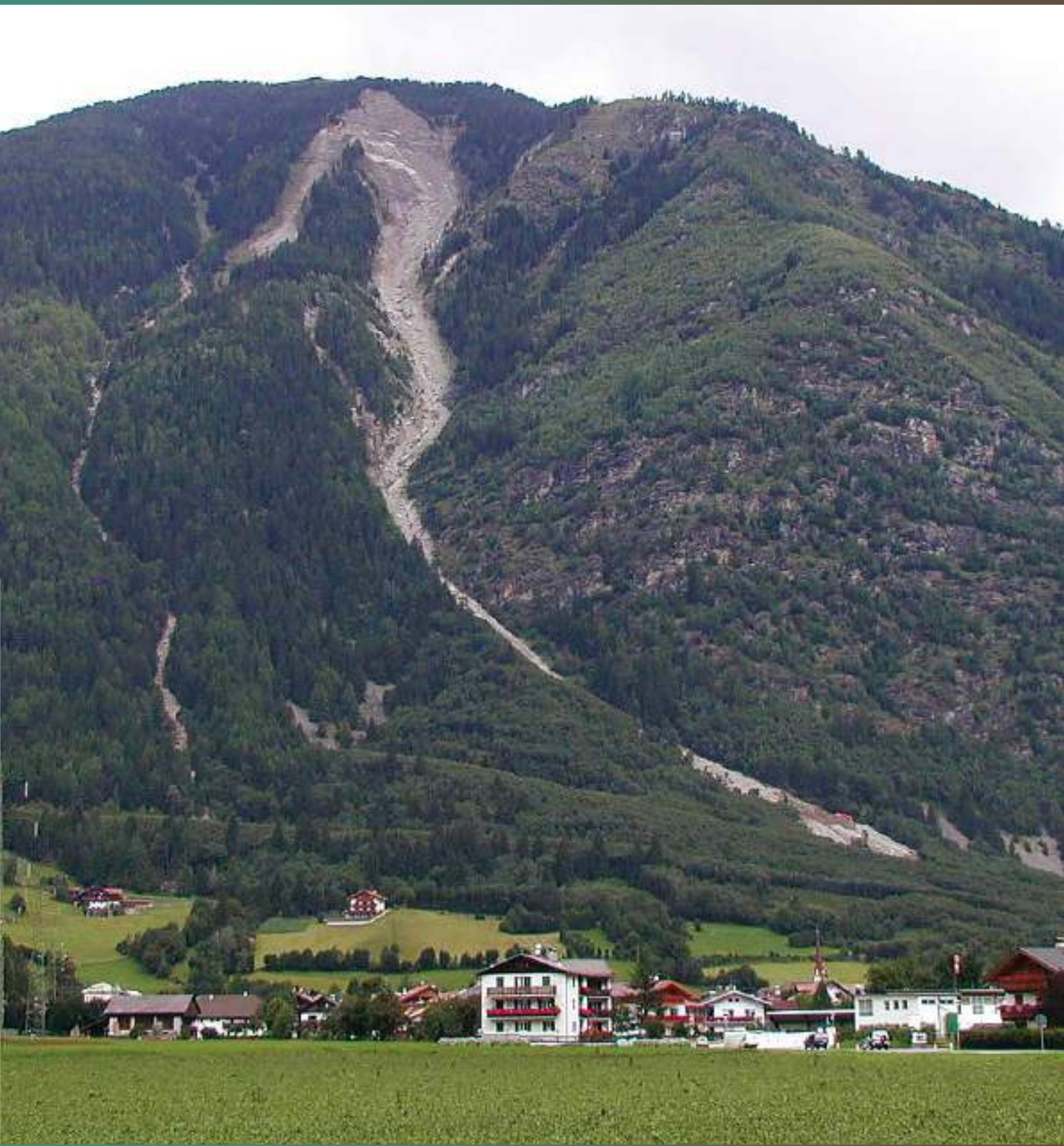
Foto 8.18 Frana sovrastante l'abitato di Molini di Tures - Intervento 084/99 - Campo Tures (BZ) Fonte ISPRA Elisa Brustia - Roberto Pompili
