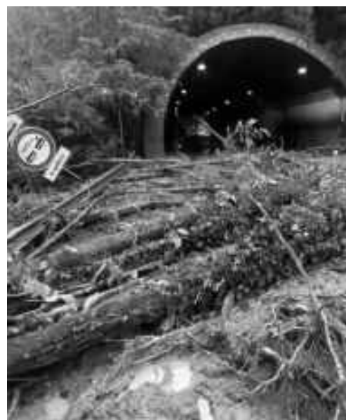
4 ottobre 2021 | Frana sull'A26 dovuta alle forti piogge
