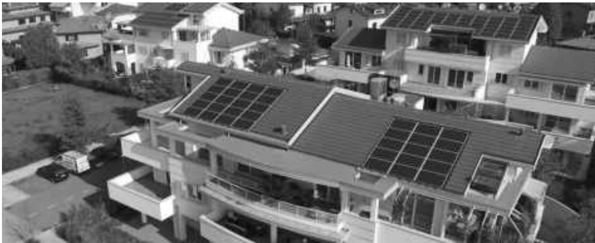
Ecovillaggio Montale, Modena
