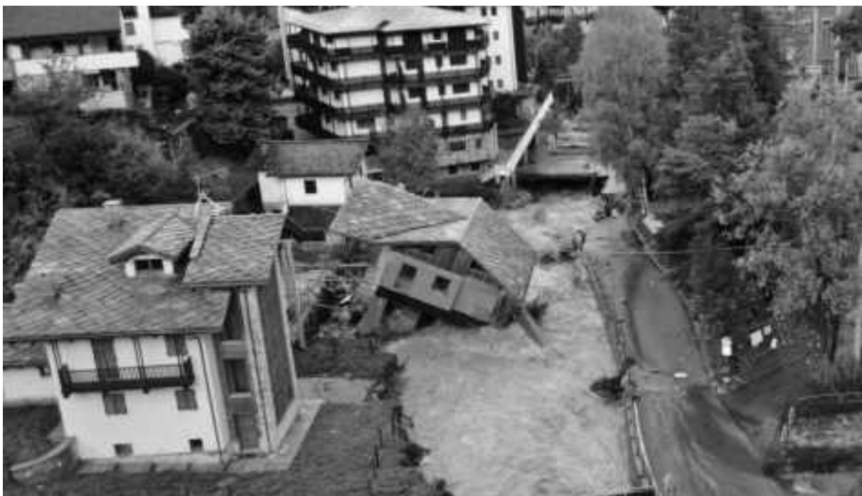
3 ottobre 2020 | Alluvione a Limone Piemonte (CN) con danni ad abitazioni ed interruzioni di strade
