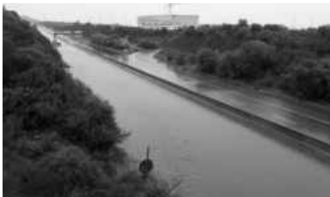
10 ottobre 2018 | Alluvione a Capoterra (CA) sulla statale 195
